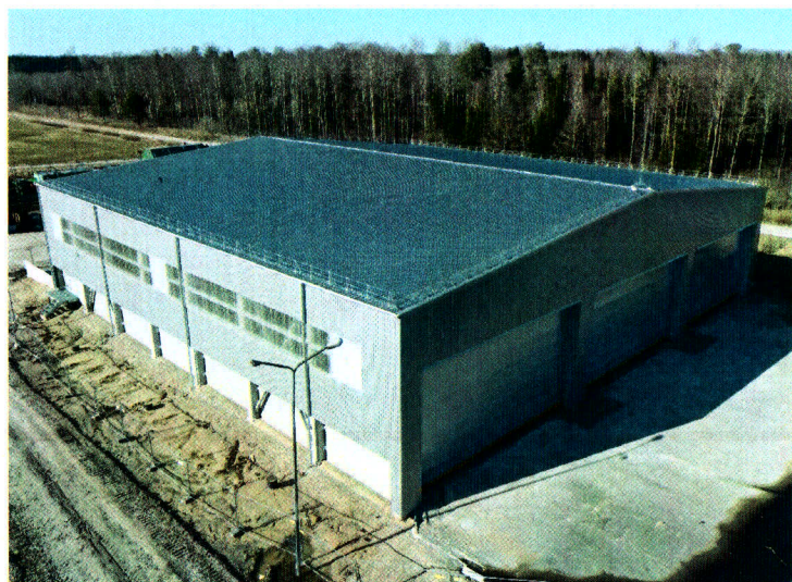
2 pav. MVA apdorojimo pastatas
