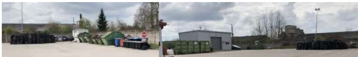
Pav. 23 DASA aikštelė
