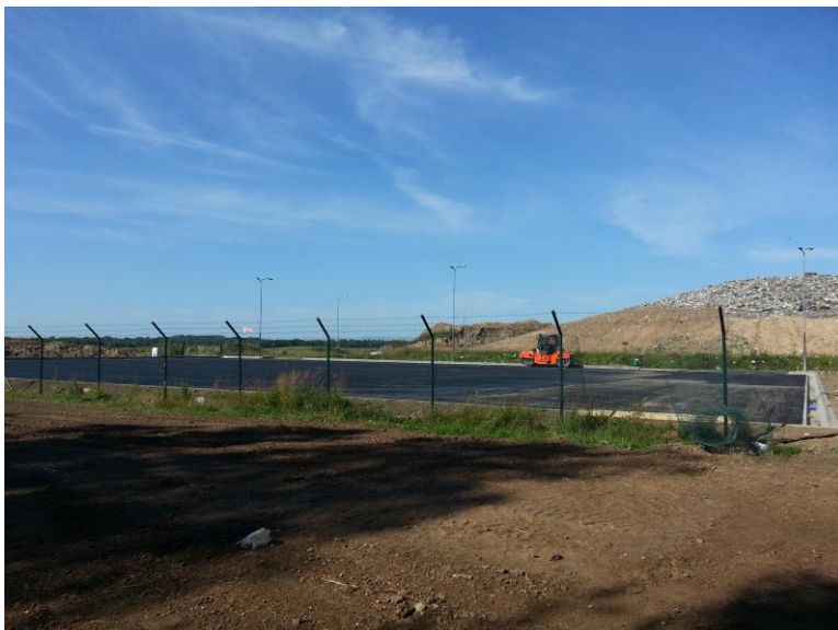
19 pav. BSA aikštelės statyba
